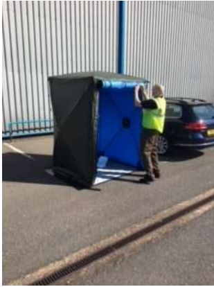
Fig 7a). Car park erection
